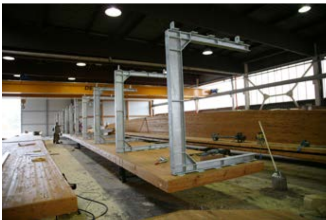
▲ Fasi di costruzione in stabilimento della passerella di Locarno
