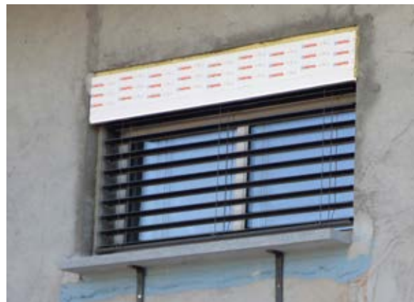
◀ Controtelaio + serramento e frangisole prima della posa del cappotto esterno. Cantiere di Taino (VA)
