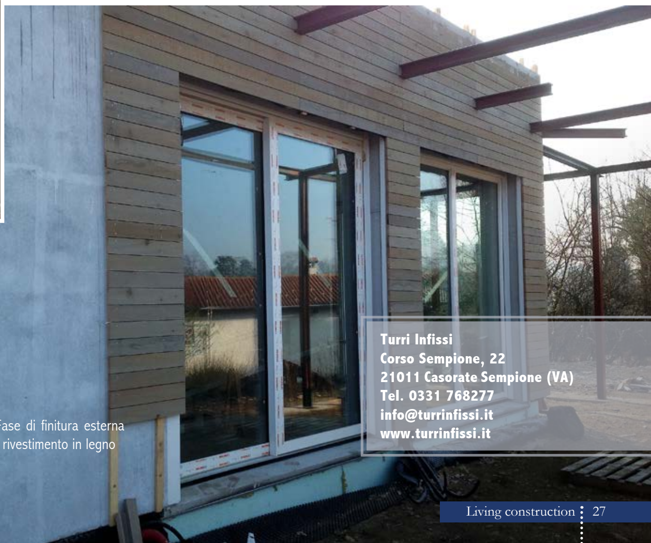
◀ Controtelaio + serramento e frangisole prima della posa del cappotto esterno. Cantiere di Taino (VA)
