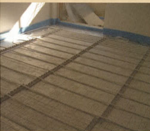
Esempio di posa delle serpentine per la realizzazione del riscaldamento a pavimento.
