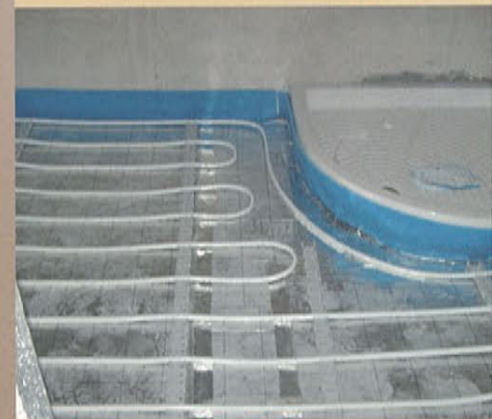
Esempio di posa nel locale bagno, prima della gettata di sottofondo.
