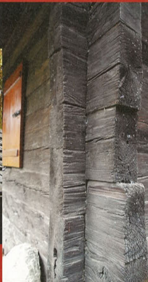
Dettaglio del cosiddetto blok-bau, legno incastro
